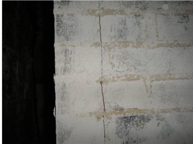
Ejemplo de fractura en recubrimiento exterior de obra
